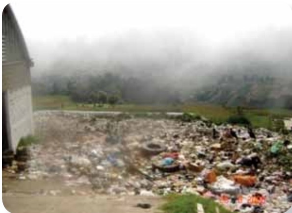
Planta de tratamiento de basura, Almolonga, Quetzaltenango.
