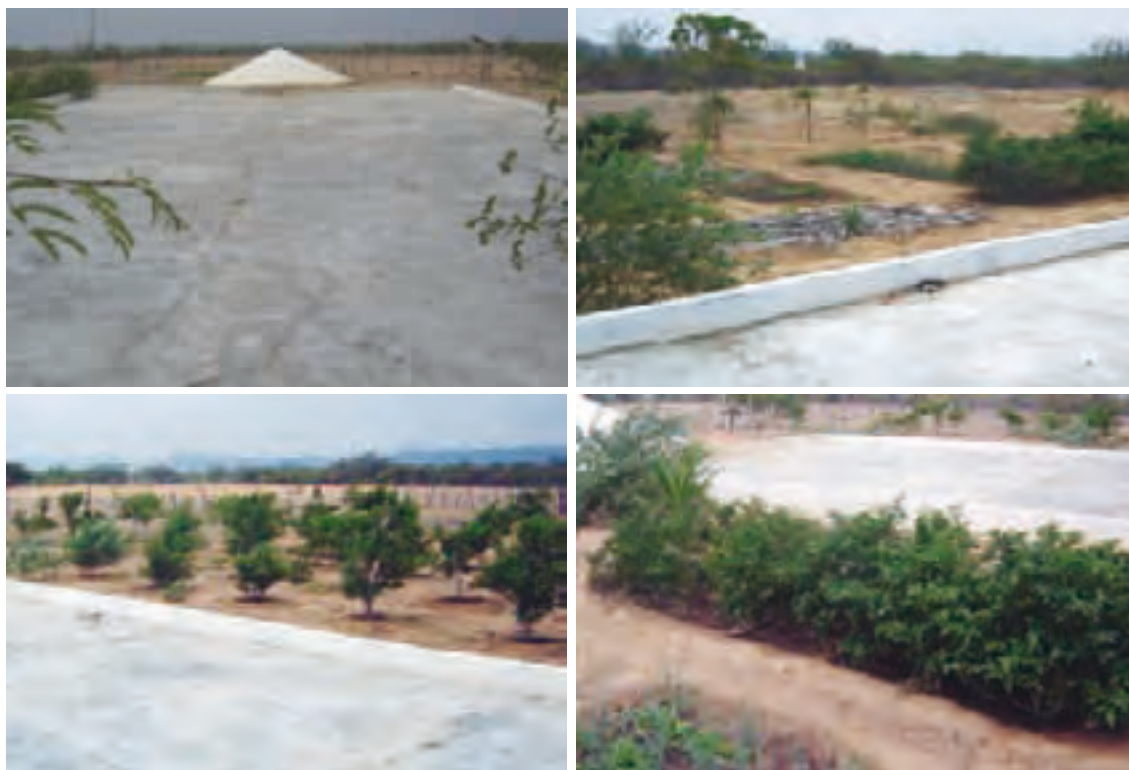
FIGURA 14-V: Patio y cisterna en hormigón para abrevadero de animales y riego en pequeño huerto, promovido por el IRPAA-Brasil.
