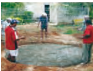
FIGURA 17-V: Detalles constructivos del modelo de cisterna hecho con malla de alambre y mezcla de cemento y arena.
