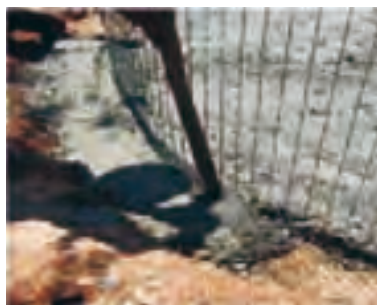
FIGURA 17-V: Detalles constructivos del modelo de cisterna hecho con malla de alambre y mezcla de cemento y arena.
