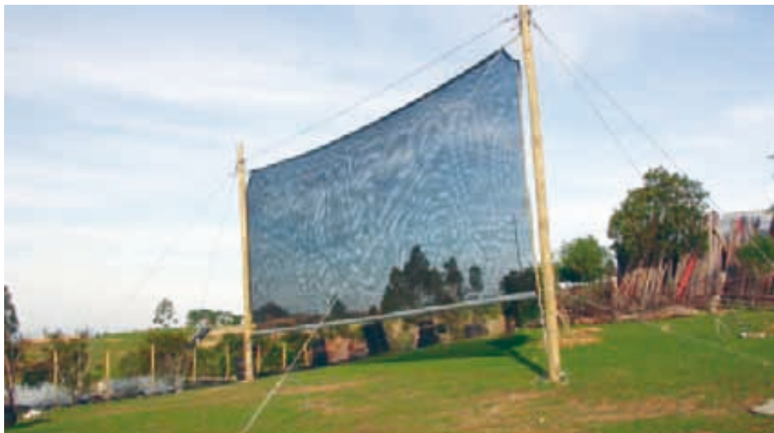
FIGURA 16-I: Panel de malla atrapaniebla para la captación de humedad atmosférica en la Comuna de Navidad, Región de O'Higgins, Chile.
