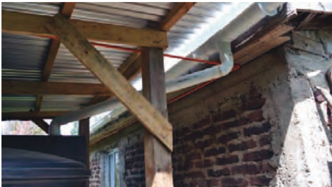
FIGURA 14-IV: Sistema de acople entre el tubo de conducción de agua y la estructura de almacenamiento.
