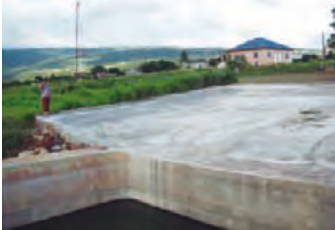
FIGURA 17-XIV: Patio y cisterna de hormigón.
