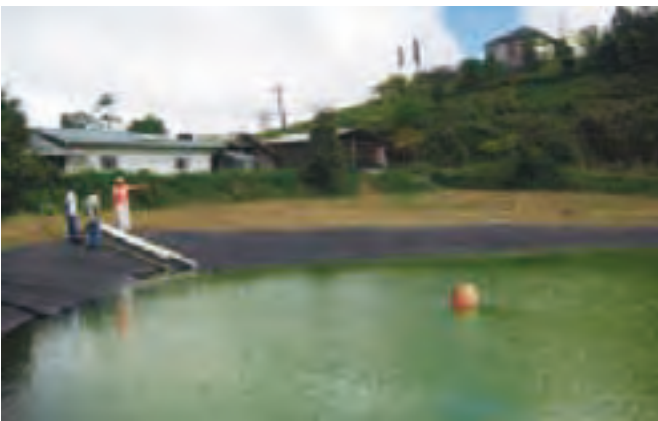
FIGURA 17-XV: Estanque excavado de almacenamiento de agua revestido con una manta de material sintético PPL-24 (polietileno reforzado de 24 mil, con 5 capas: 3 de baja densidad y 2 de alta densidad intermedia).
