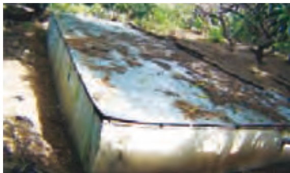
Estanque de hormigón para almacenamiento primario en la captación del yacimiento y derivación para pequeño riego. Note que la tapa evita que la basura contamine el agua y cause problemas de tapo-namiento o contaminación. Foto: José Cristóbal Escobar Betancourt.
