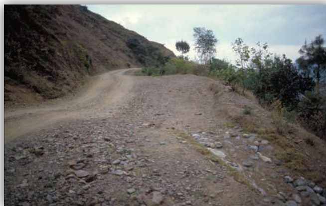
Figura 13. Vado ondulante superficial como drenaje transversal, para desalojar el agua fuera de la superficie del camino de manera eficiente y económica, sin tener que usar tubos de alcantarilla.
